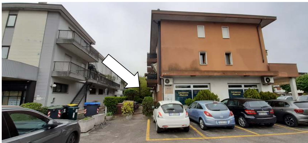
Vista del Condominio con indicata la posizione dell'ingresso al magazzino
