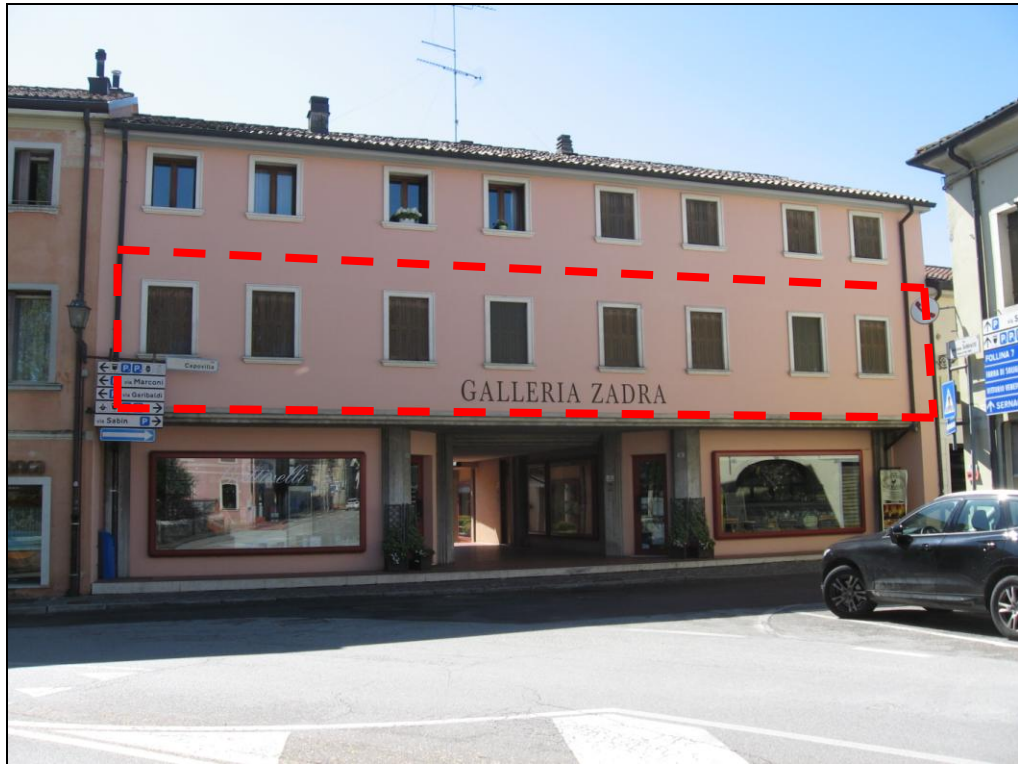
vista dell'affaccio Nord/Ovest dell'immobile oggetto di esecuzione
