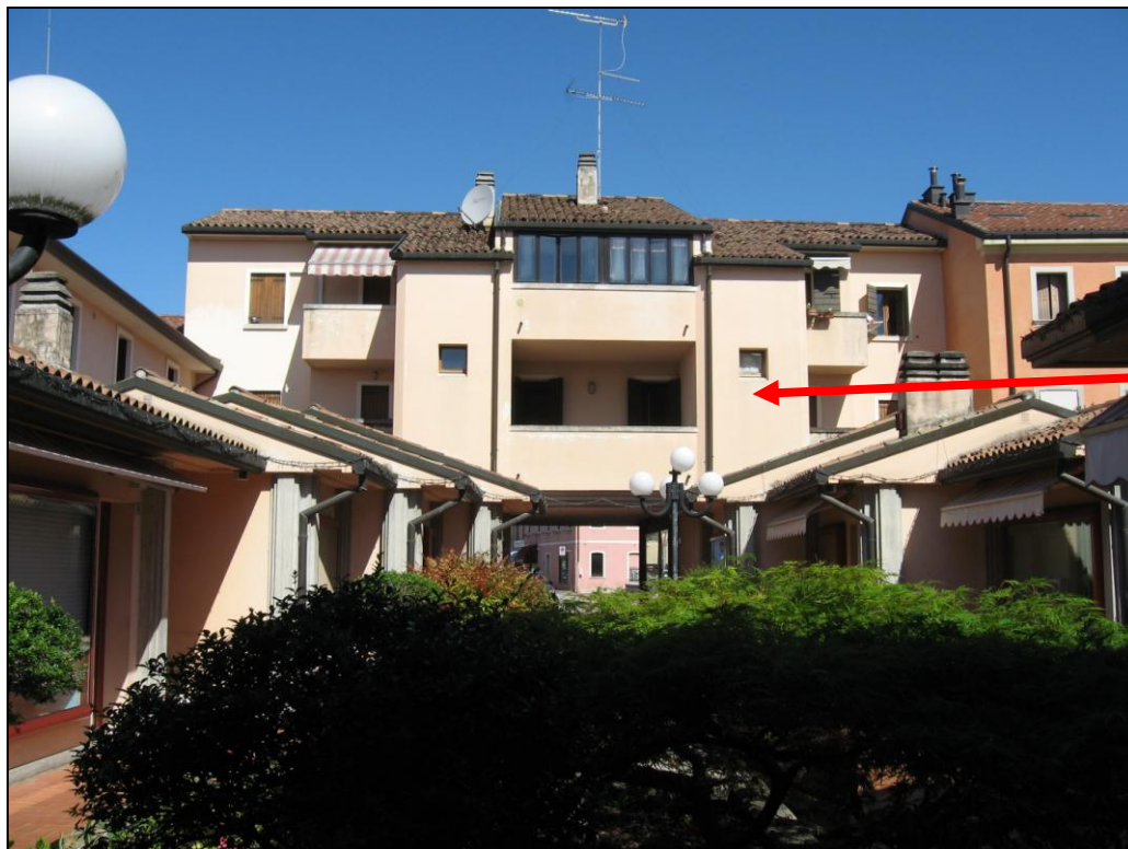
vista dell'affaccio Sud dell'immobile dalla corte comune interna
