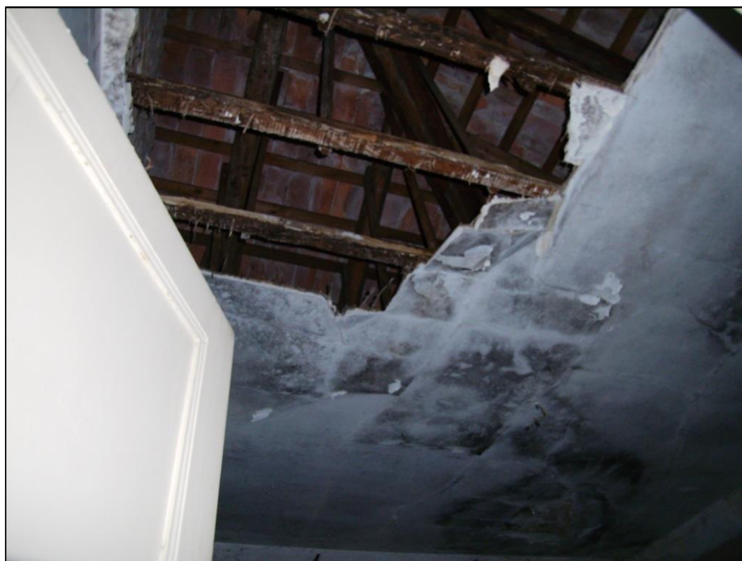
14) abitazione 1 - soffitto camera
