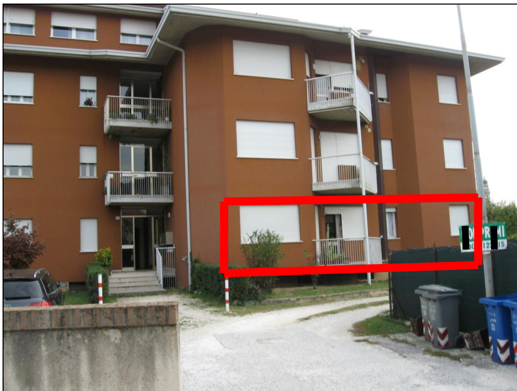
vista dell'affaccio Sud/Ovest dell'appartamento oggetto di esecuzione
