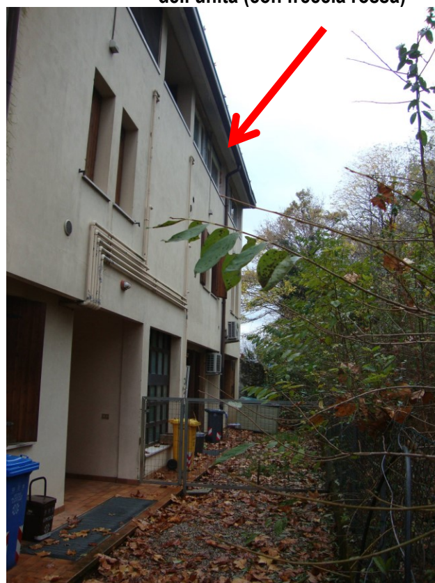
Fig. 20 – vista da nord-est del fabbricato e dell'unità (con freccia rossa)
