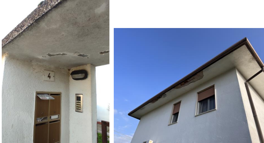
Ingresso pedonale e intradosso copertura
