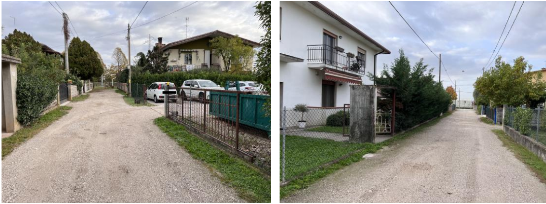
Accesso carraio e accesso pedonale al fabbricato
