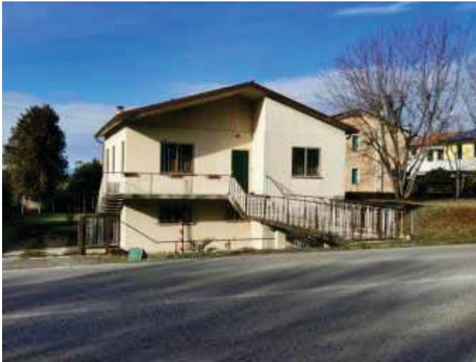
Foto n. 1_ Inquadramento generale del compendio.
