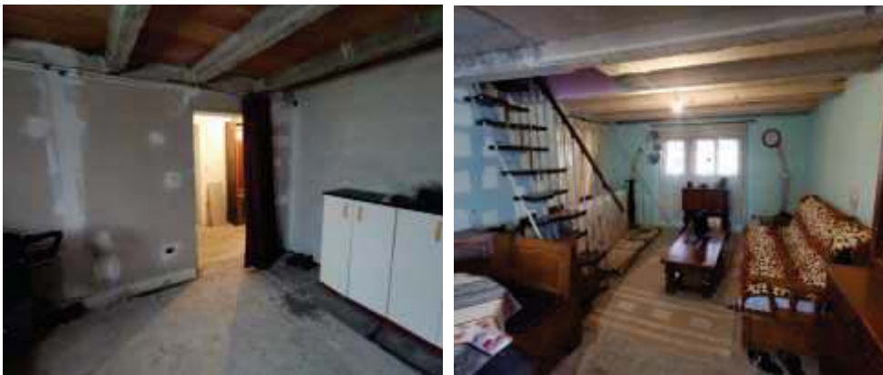
Foto n. 3 _ Panoramiche interne piano terra
