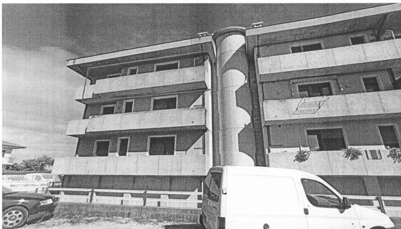
Condominio fronte Sud
