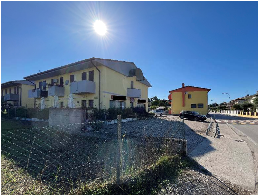
N.1 – Ingresso da via San Marco
