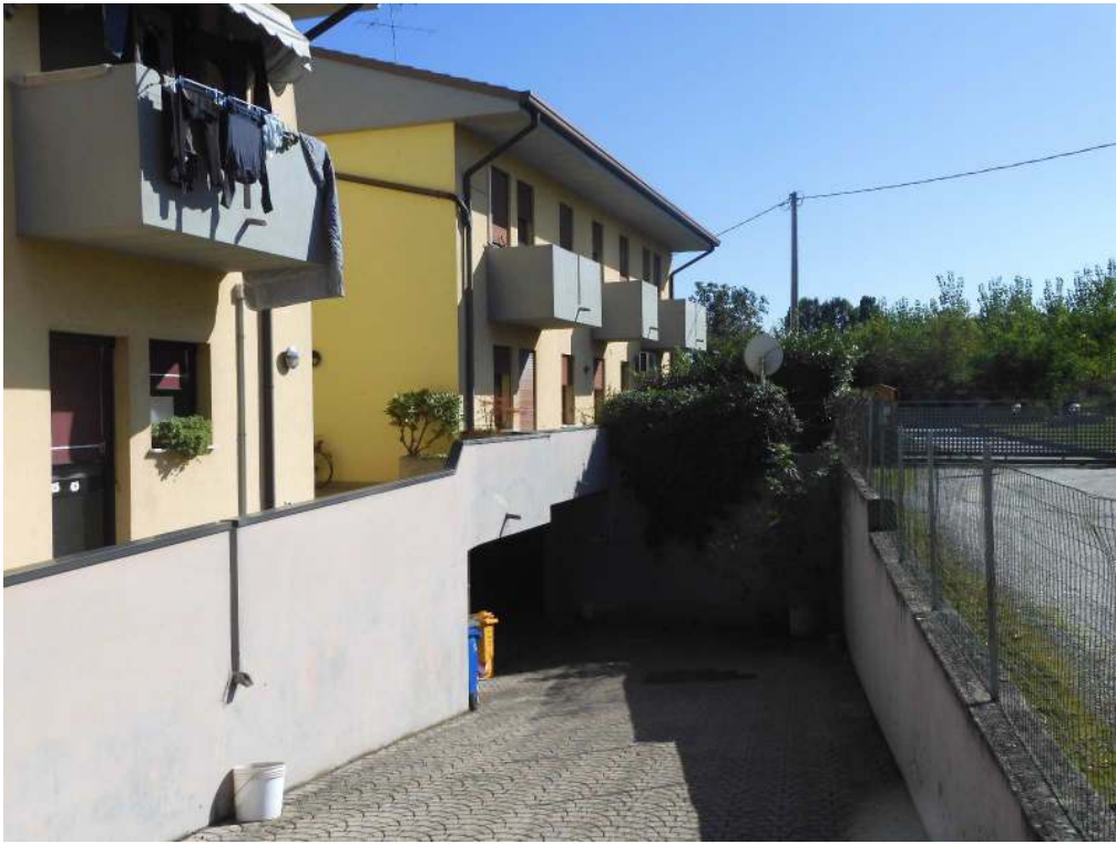
N.23 – Rampa garages
