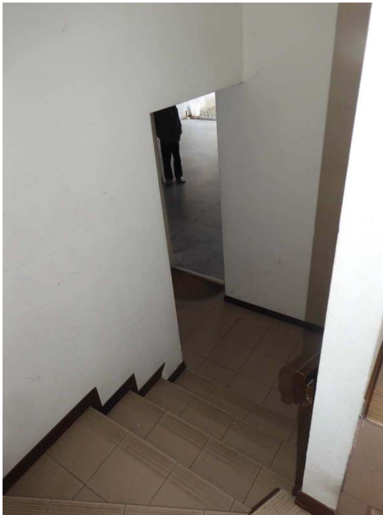
N.18 – Vista scala verso piano interrato
