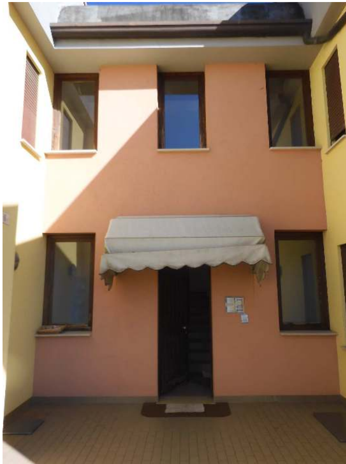
N.5 – Ingresso comune piano terra
