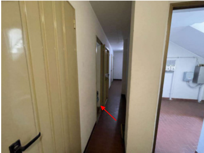
foto n. 17 – accesso alla cantina al piano terra
