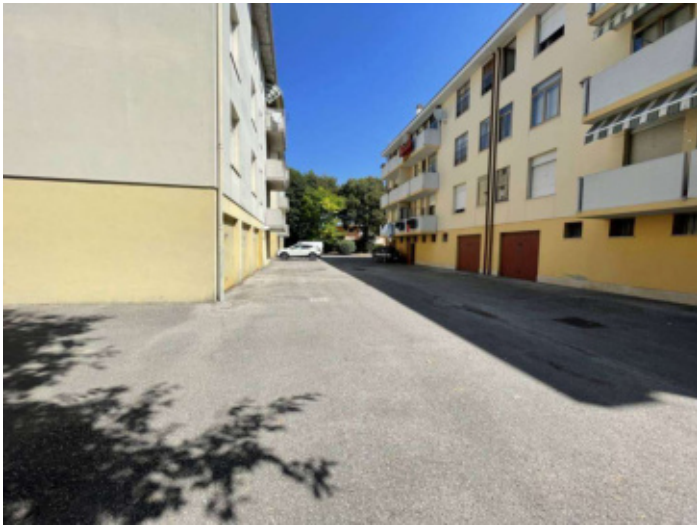
foto n. 23 – area scoperta tra fabbricati condominiali
