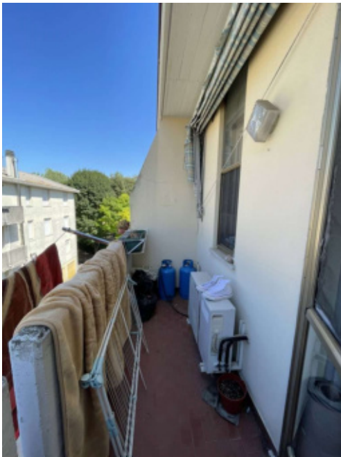
foto n. 9 – terrazzino prospetto ovest
