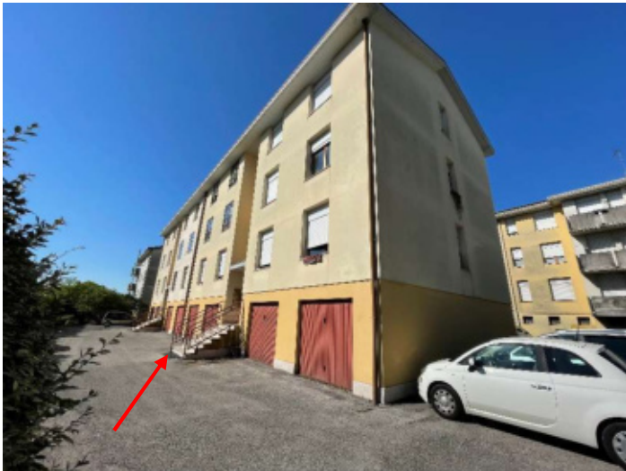
foto n. 1 – prospetti est e nord con ingresso scala A
