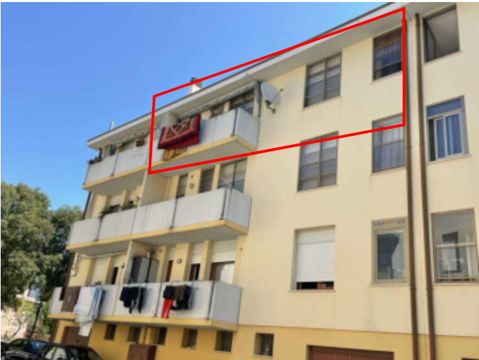
foto n. 3 – prospetto ovest - appartamento
