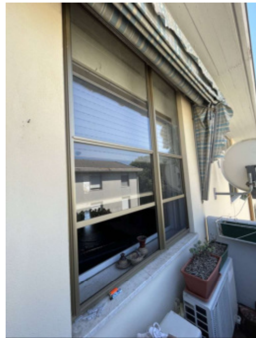
foto n. 10 – terrazzino; particolare doppia finestra con apertura a ghigliottina
