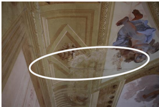
Dettaglio fessurazione
