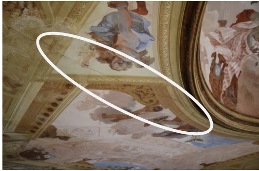
Dettaglio fessurazione
