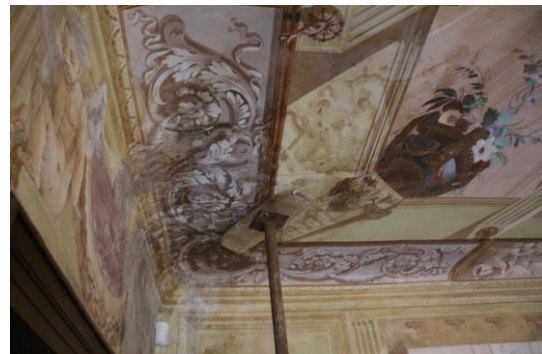
Dettaglio sostegno provvisorio area di infiltrazione
