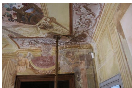
Dettaglio infiltrazione
