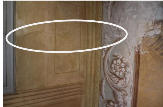
Dettaglio fessurazione
