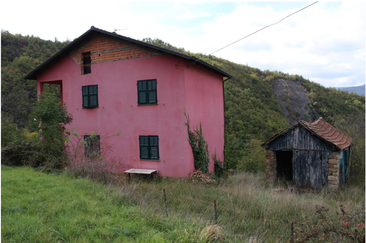
FOTO n°2. - visione tipica fabbricati/ruderi oggetto di stima
