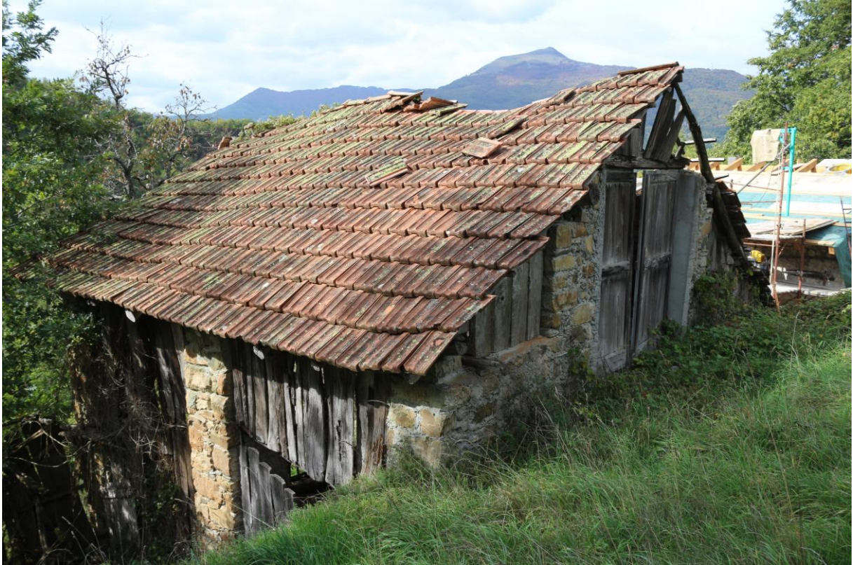
FOTO n°1. - visione tipica fabbricati/ruderi oggetto di stima
