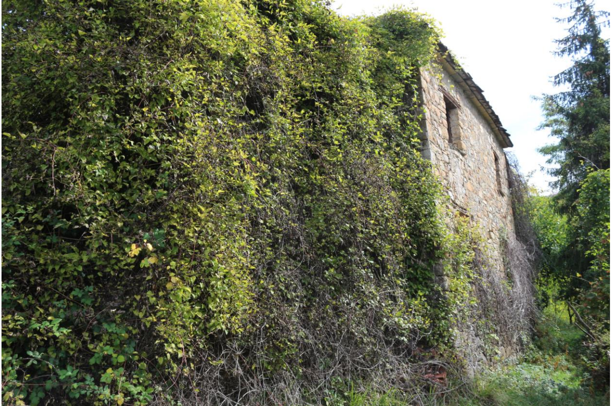
FOTO n°5. - visione tipica fabbricati/ruderi oggetto di stima
