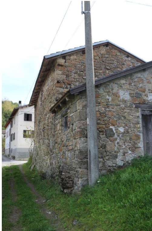
FOTO n°3. - visione tipica fabbricati/ruderi oggetto di stima
