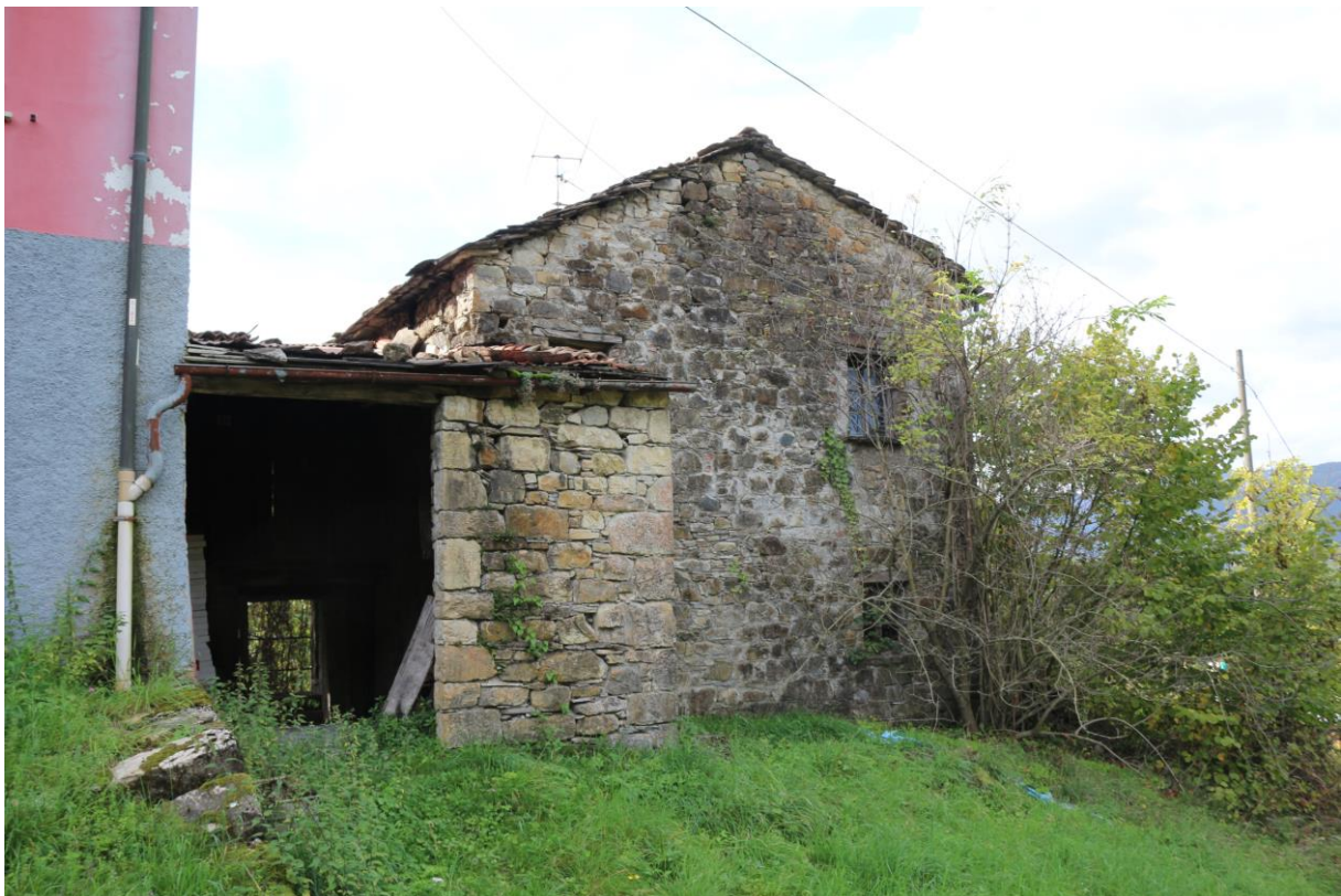
FOTO n°4. - visione tipica fabbricati/ruderi oggetto di stima
