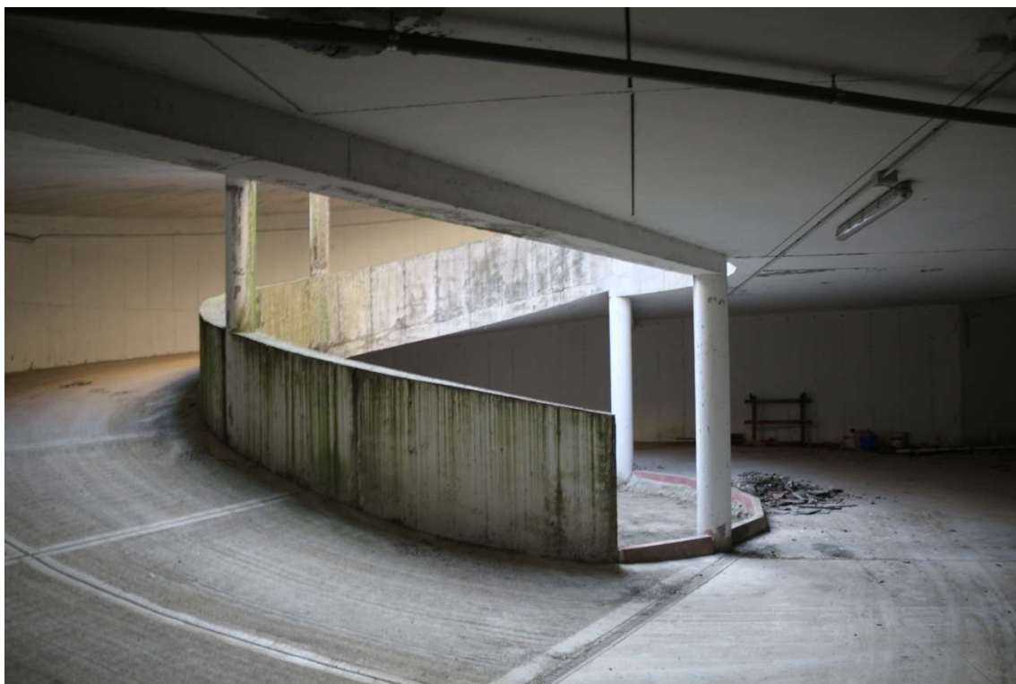
FOTO n°6 - visione rampa di accesso ai posti auto – LOTTO 3.2
