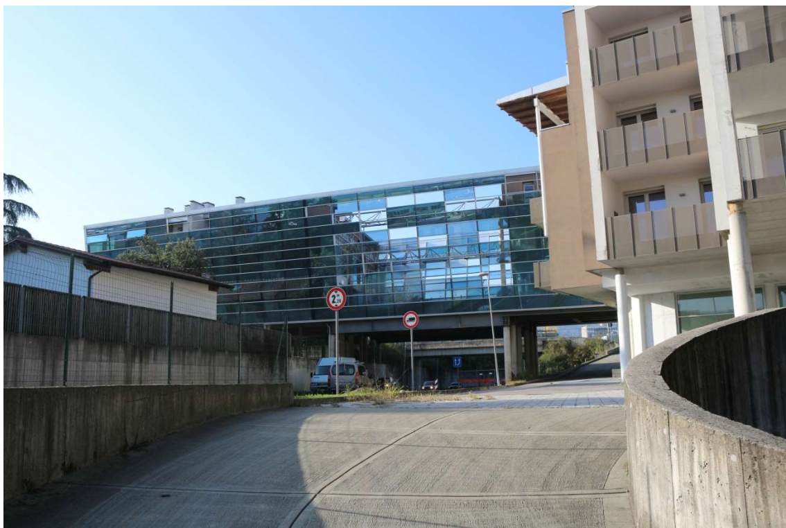
FOTO n°5 - visione rampa di accesso ai posti auto – LOTTO 3.2
