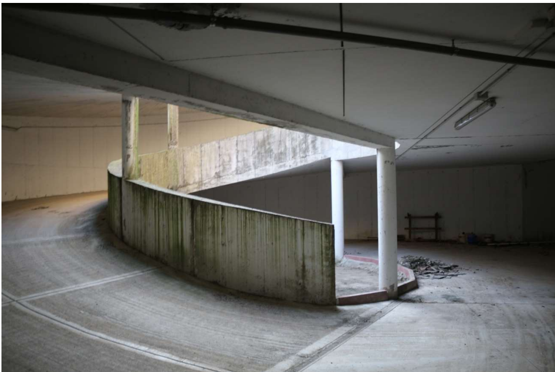
FOTO n°6 - visione rampa di accesso ai posti auto – LOTTO 3.1
