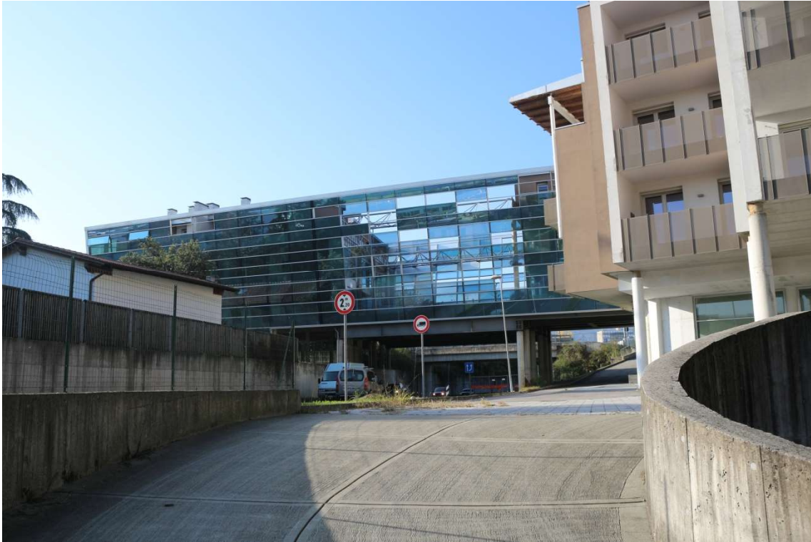
FOTO n°5 - visione rampa di accesso ai posti auto – LOTTO 3.1
