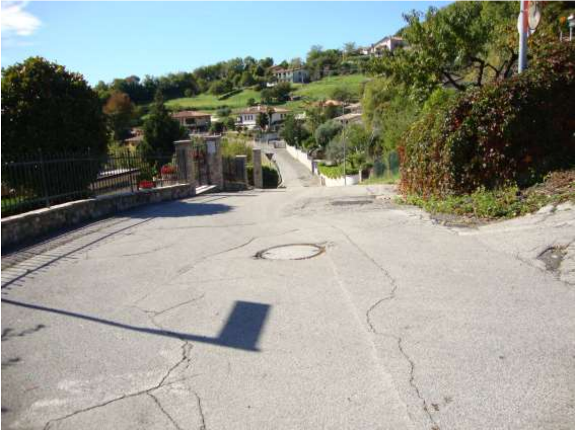
Fig. 16 – vista della via G. Verdi
