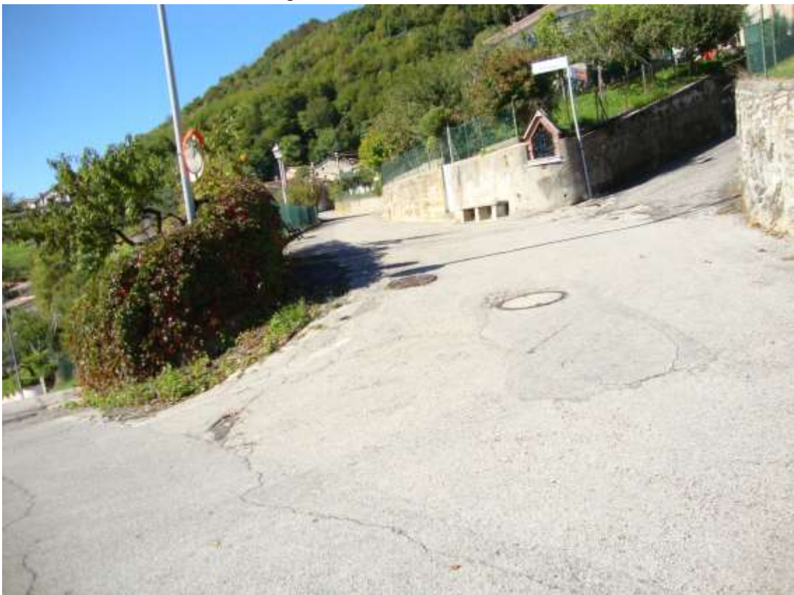
Fig. 15 – vista della via G. Verdi
