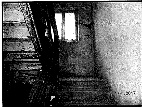
Scala interna in legno
