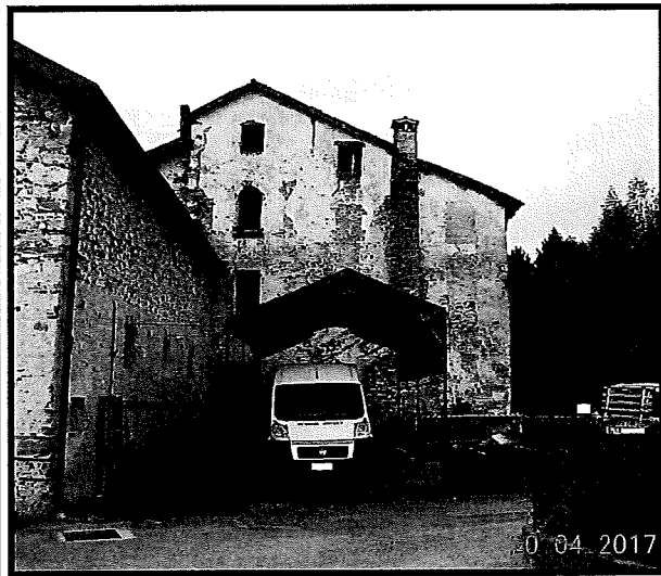
Vista prospetto est (struttura prefabbr.)
