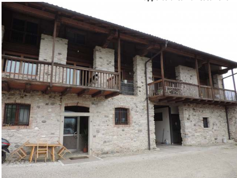
Lato Sud (sub3)
