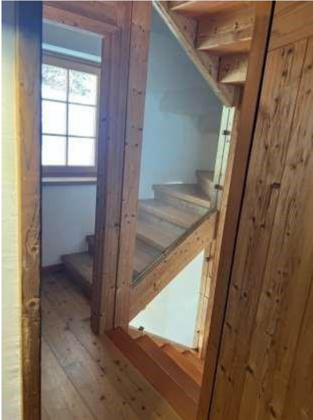
Foto 15: P1 vano scale di collegamento al PT e P2-sottotetto
