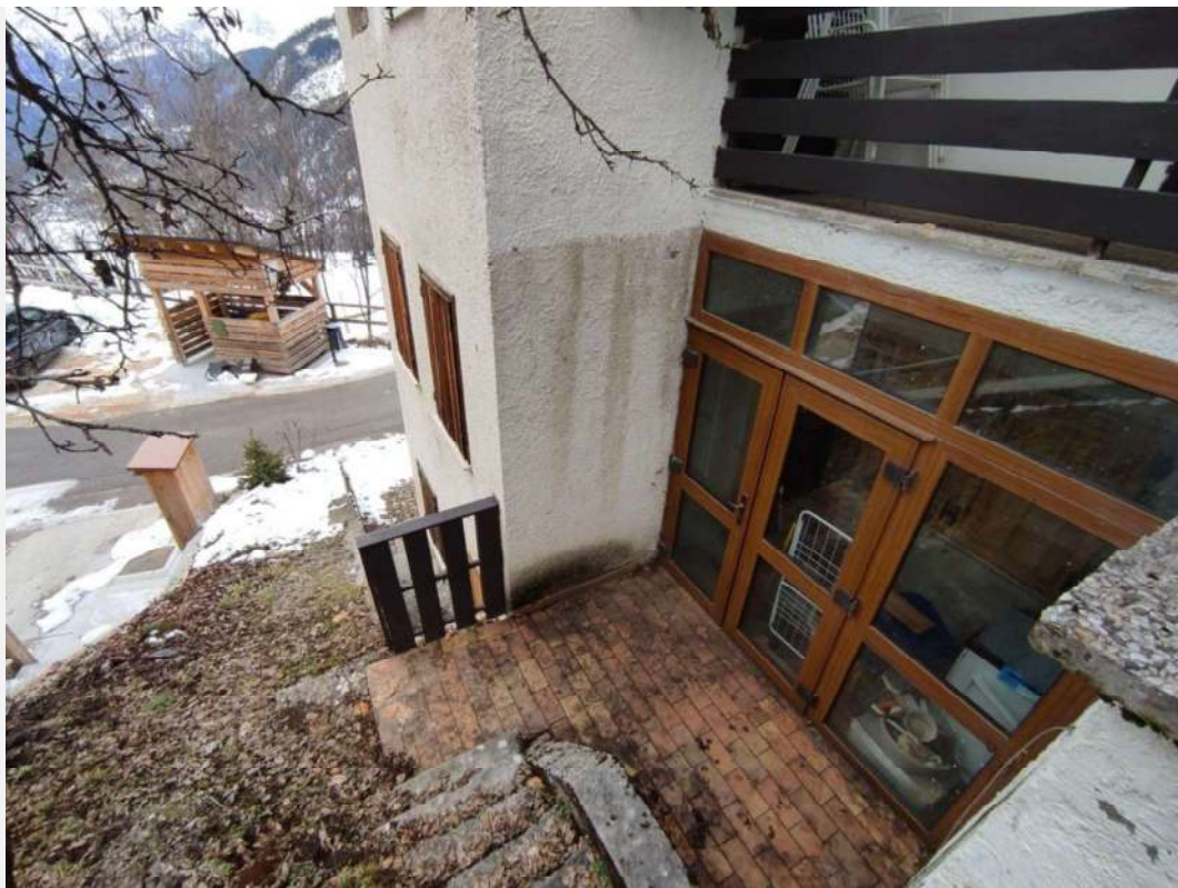
foto 4 – Particolare andito esterno e veranda verso via Coldemies
