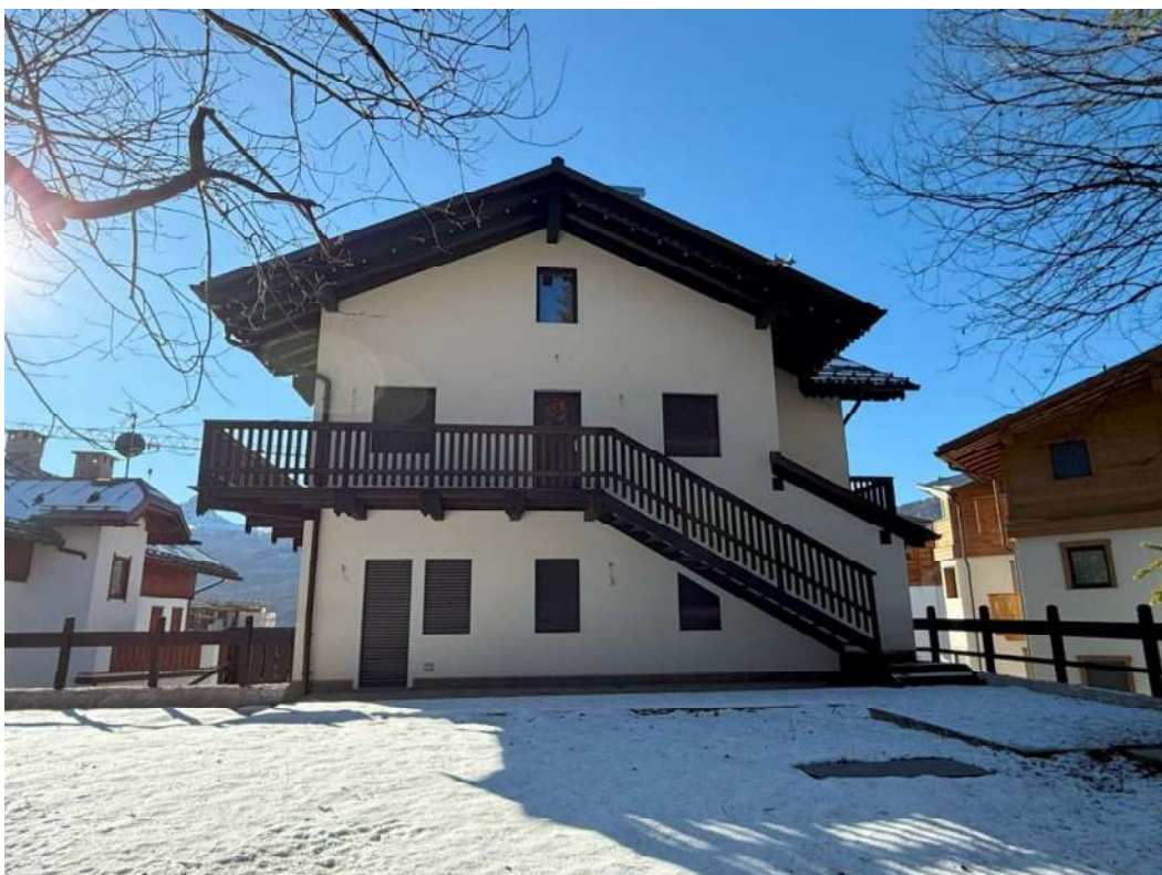
Foto 04: fronte Nord-Est condominio “Ca’ del Mejo”
