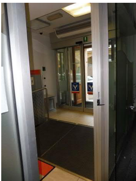
22 Gli uffici dell'ala nord-est
