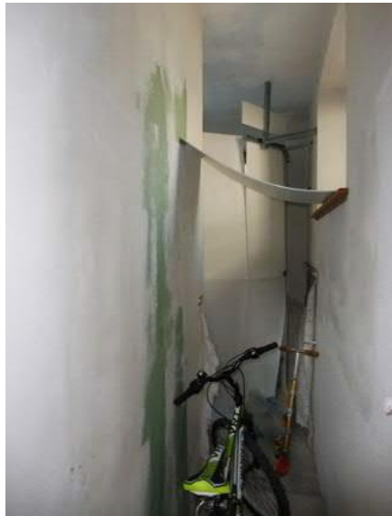
49 Lo stretto corridoio interno
