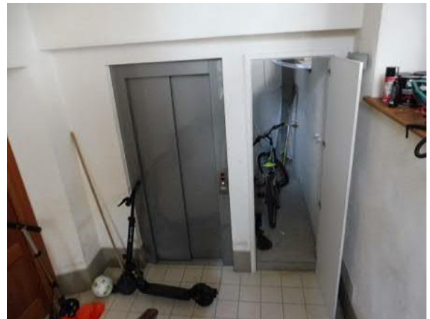
48 L'ingresso al ripostiglio dal vano scala
