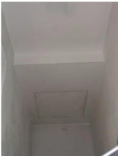
55 Botola nel soffitto
