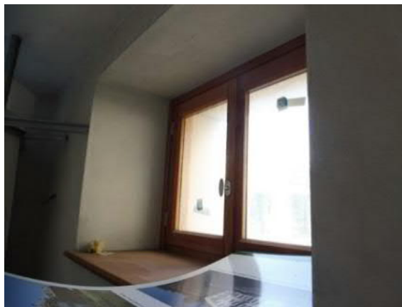
51 Finestra nel corridoio interno
