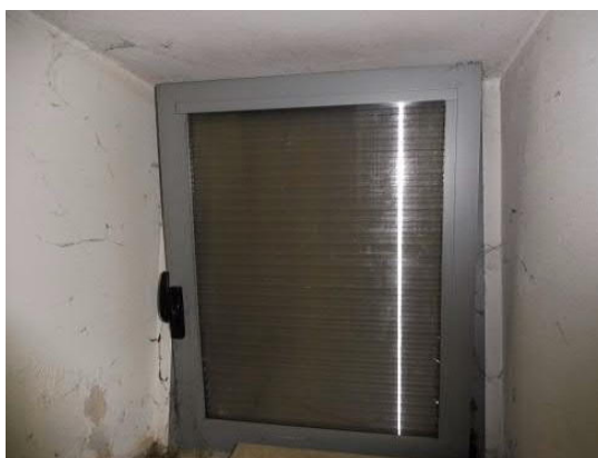
59 Il serramento che si affaccia nella bocca di lupo
