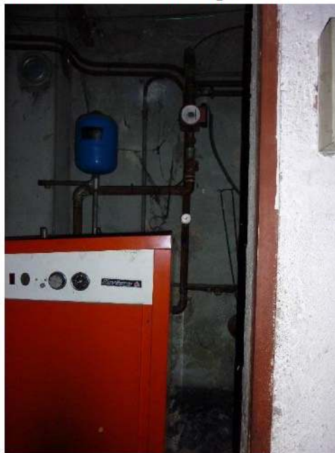
Centrale termica (con locale annesso alla Cantina)
