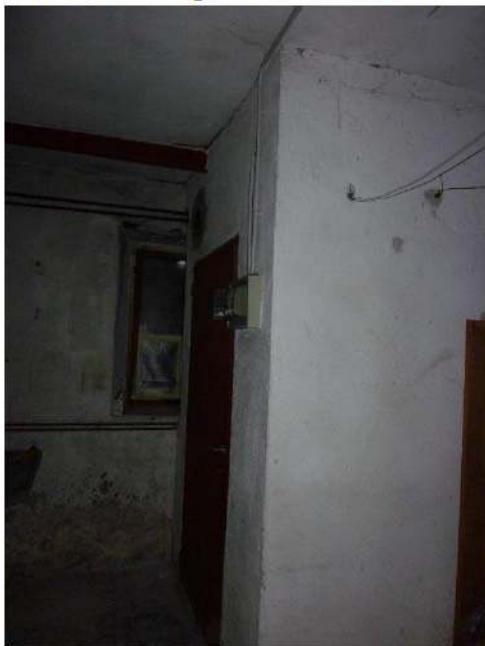
Cantina al piano terra con pavimento da mq.12
