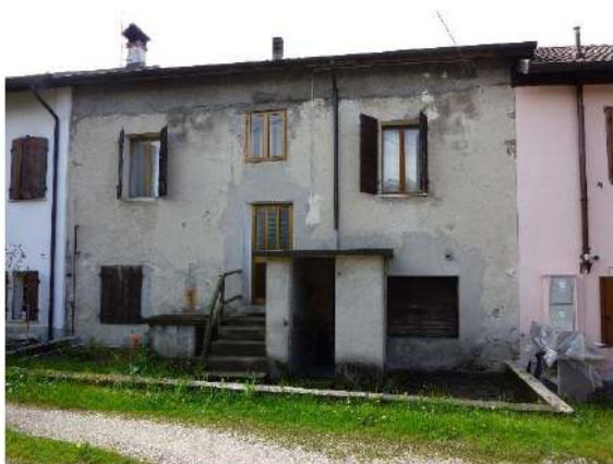
Prospetto principale (lato nord)
