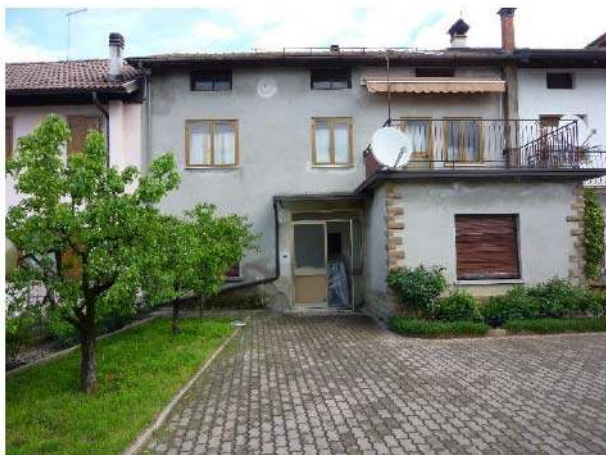
Vista dell'ingressa sul lato sud
