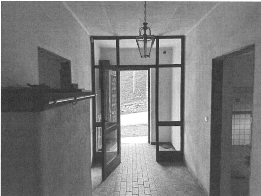
Foto 20: PT (sub. 3) ingresso
