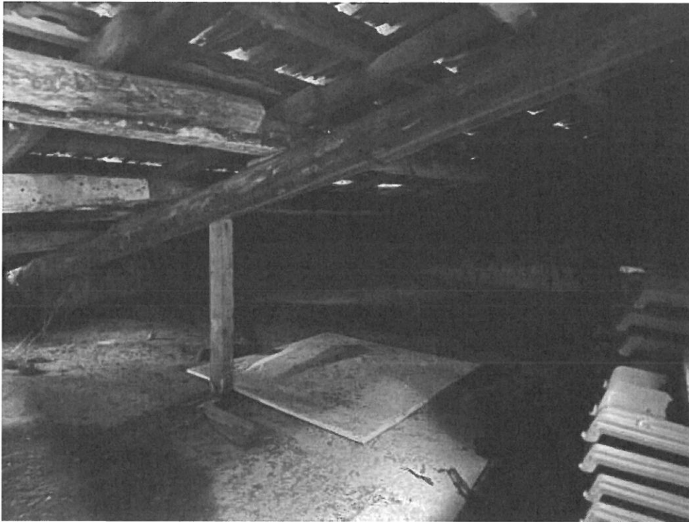
Foto 35: P1 (sub. 3) soffitta metà piano fronte Nord-Est
