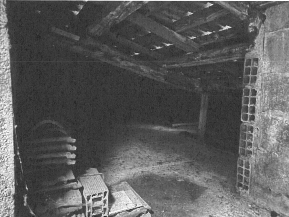
Foto 34: P1 (sub. 3) soffitta metà piano fronte Nord-Est
