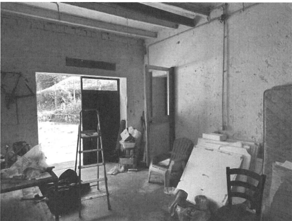
Foto 08: PS1 (sub. 2) autorimessa
