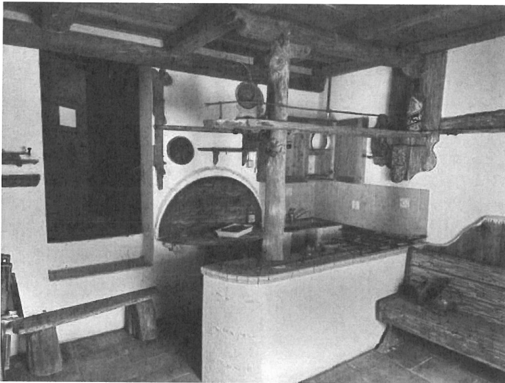
Foto 09: PS1 (sub. 3) locale cantina
