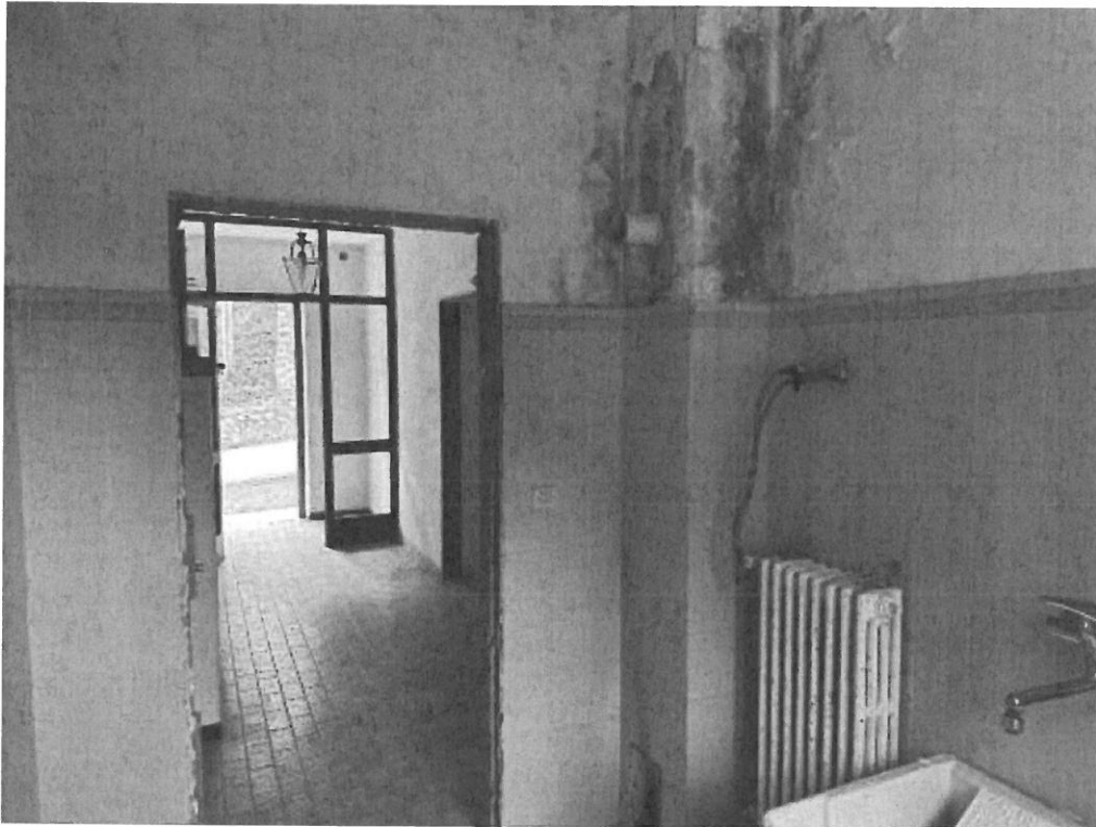
Foto 21: PT (sub. 3) bagno
