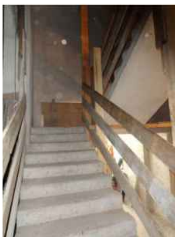
vano scala interno al grezzo
