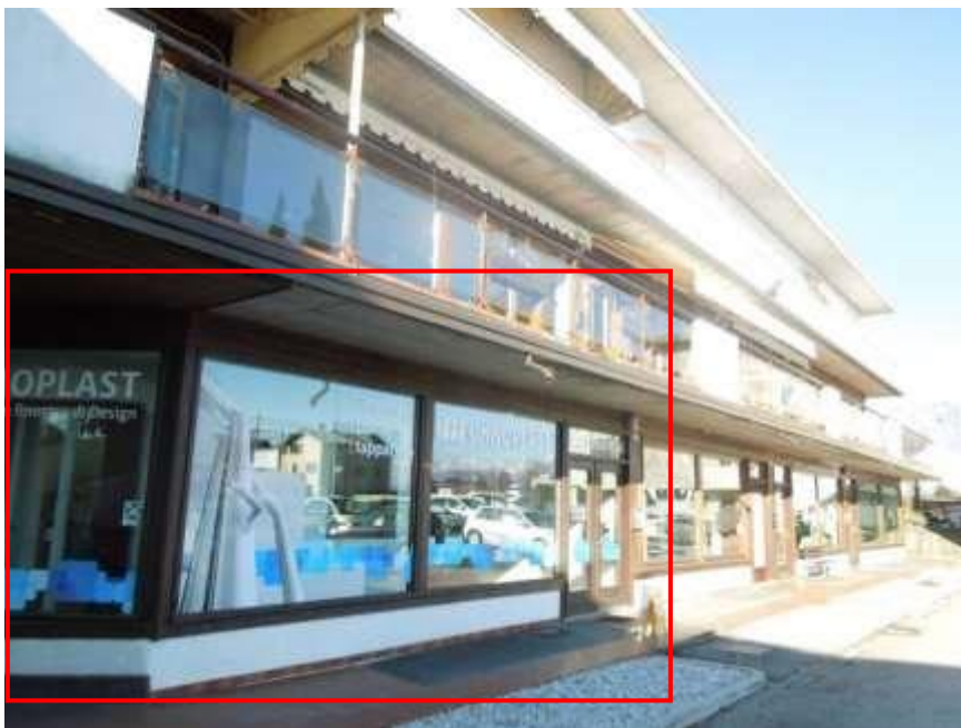
11: vista esterna Sud dell'unità immobiliare.
