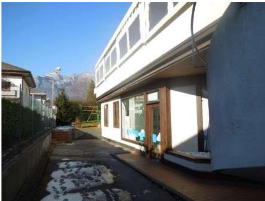
12: vista Ovest dell'unità immobiliare.
