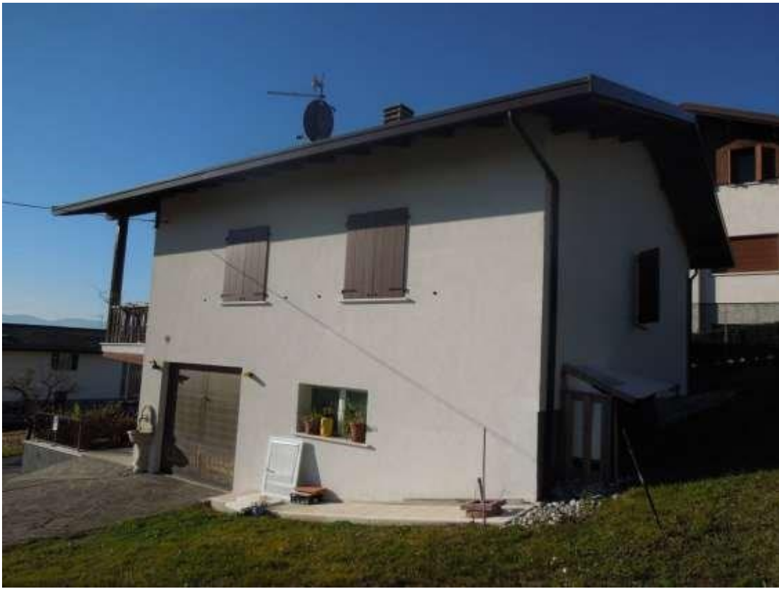
25: prospetto Nord dell'edificio.
