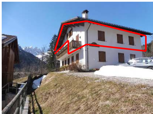
1 Vista dei lati nord-est e sud-est
