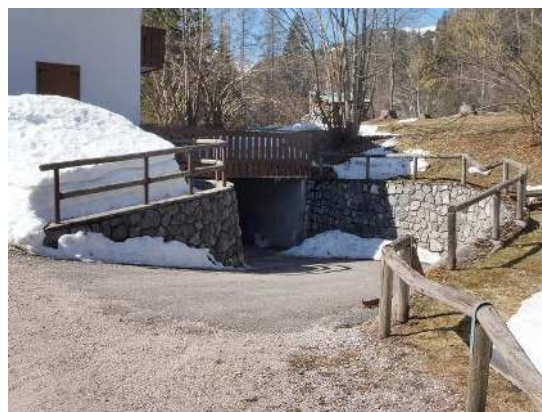
6 La rampa d'accesso al piano interrato
